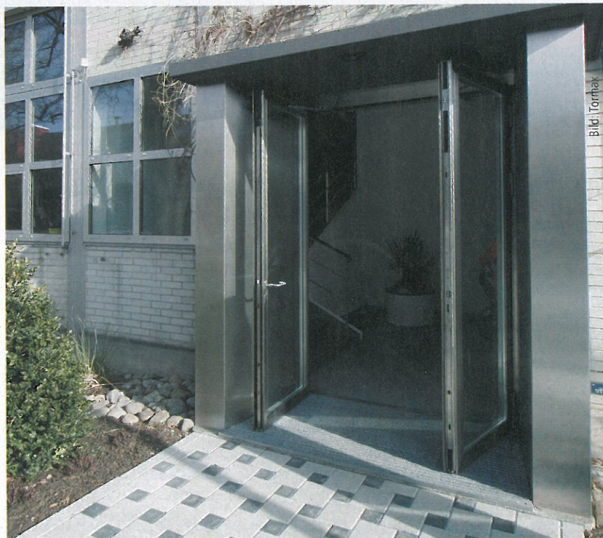
Drehflügeltüren - die ältesten uns bekannten Türen: Heute sind sie automatisiert und mit Sicherheitsfunktionen ausgestattet.
