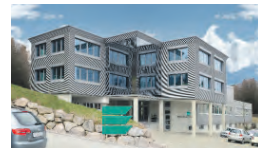
Bürogebäude Eichenberger Gewinde AG
